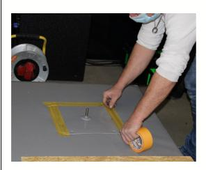
Über Rand des Montagefußes wird ein 40 mm breites Klebeband als Schleppstreifen geklebt (zum Schutz der Dachbahn, sollte der Übergang zu grob sein)
